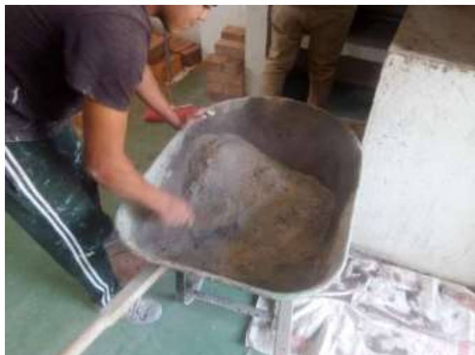
Figura 50. Fabricación de mortero, mezcla manual de materiales de cemento y arena. Fuente: Autores.
