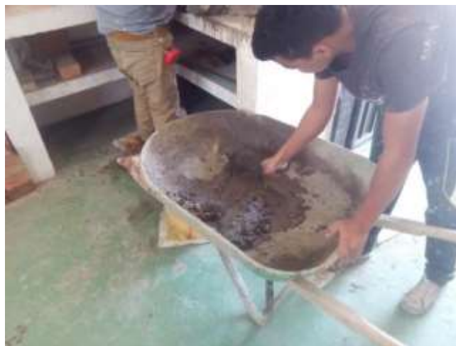
Figura 51. Fabricación de mortero. Fuente: Autores.
