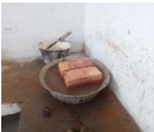
Figura 52. Fabricación y pre-humedecimiento de unidades de mampostería. Fuente: Autores.
