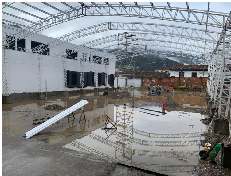
Figura 2. Fotografía del avance de obra de la construcción del coliseo cubierto. Obtenido del Ing. Jose Alberto Páez Sánchez, 2021
