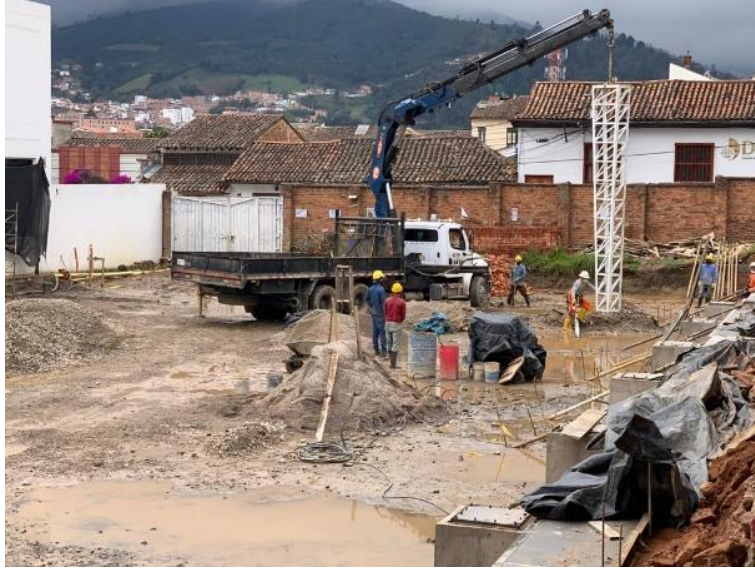
Figura 5. Uso de grúa camión. Obtenido de Ing. Jose Alberto Páez Sánchez, 2021.
