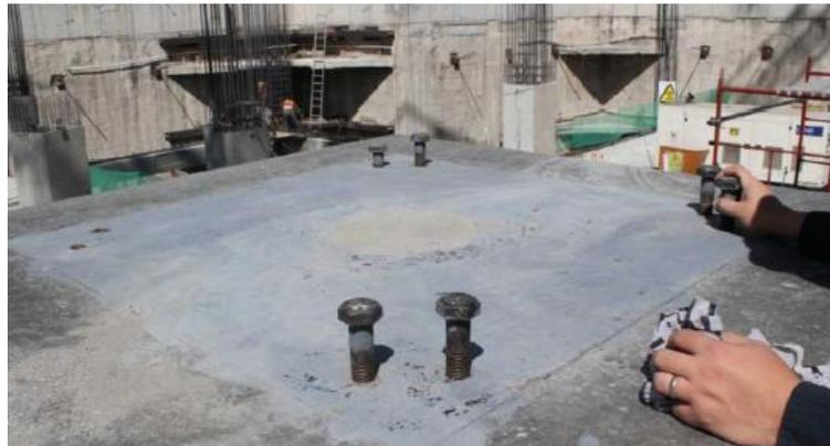
Figura 19. Verificación de los pernos de anclaje del aislador sísmico. Méndez, C. *Aislamiento sísmico de megaestructuras en Latinoamérica: Una realidad*. p. 65.
