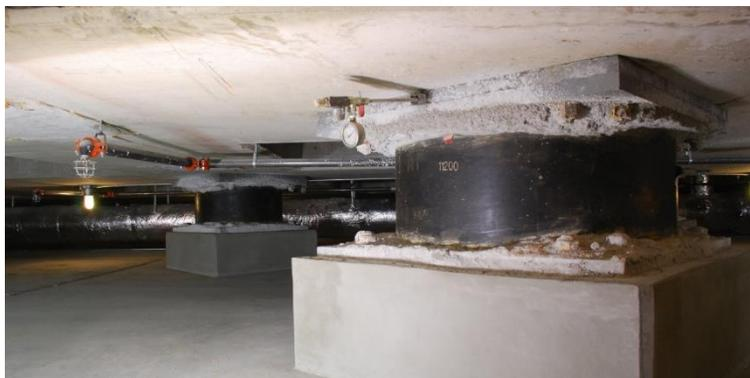
*Figura 27.* Aislador sísmico usado en Los Ángeles City Hall. Elespañol.com, 2020. Obtenido en: [https://www.lespanol.com/omicron/tecnologia/20190604/cuartel-general-apple-no-conectado-secreto-terremotos/403710981\\_0.html](https://www.lespanol.com/omicron/tecnologia/20190604/cuartel-general-apple-no-conectado-secreto-terremotos/403710981_0.html)
