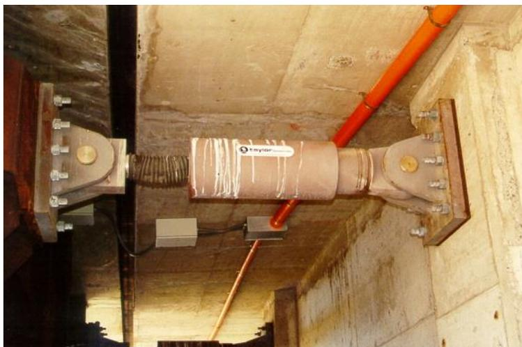
Figura 3. Disipador fluido-viscoso. Cec.uchile.cl, 2021. Obtenido en: <https://www.cec.uchile.cl/~dicesco/aislacion.html>
