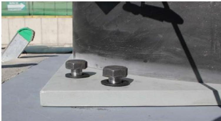
*Figura 21. Ajuste de tornillos en el aislador sísmico. Méndez, C. Aislamiento sísmico de megaestructuras en Latinoamérica: Una realidad. p. 67.*
