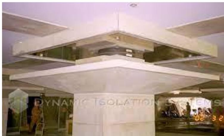
*Figura 25.* Aislador sísmico usado en el hospital Takasu. Dis-inc.com, 2020. Obtenido en: <http://www.dis-inc.com/media/new-installation-photo.html>
