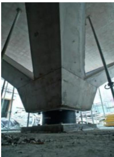
*Figura 31.* Aisladores usados en el Hospital Regional de Antofagasta, Chile. CDT.CL, 2021. Obtenido en: <https://www.cdt.cl/obras-con-proteccion-sismica-continuidad-operativa/>
