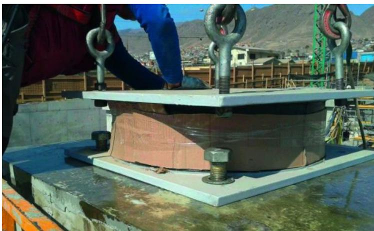
*Figura 29.* Aisladores usados en el Hospital Regional de Antofagasta, Chile. CDT.CL, 2021. Obtenido en: <https://www.cdt.cl/obras-con-proteccion-sismica-continuidad-operativa/>
