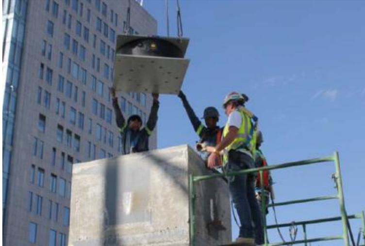
*Figura 20. Instalación del aislador sísmico. Méndez, C. Aislamiento sísmico de megaestructuras en Latinoamérica: Una realidad. p. 66.*
