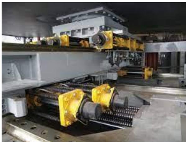
*Figura 8.* Sistema híbrido de control sísmico. Global.ctbuh.org, 2020. Obtenido en: <https://global.ctbuh.org/resources/papers/download/288-hybrid-mass-dampers-for-canton-tower.pdf>
