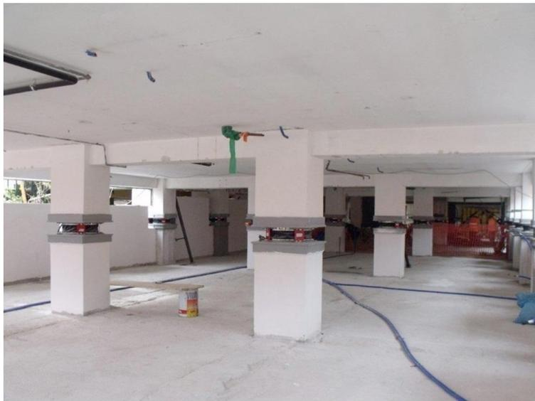
*Figura 23.* Aisladores sísmicos empleados en el edificio Bridgestone Toranomon, Japón. Gmark.org, 2012. Obtenido en: [https://co.pinterest.com/juan\\_naveda/aisladores-sismicos/](https://co.pinterest.com/juan_naveda/aisladores-sismicos/)
