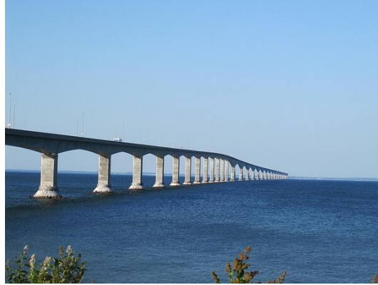
Figura 26. Puente confederaciones. Obtenido en: Estructuralia.com, 2020.
