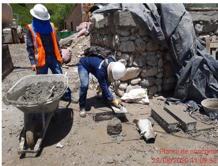
Figura 30. Elaboración de vigas de concreto. Obtenido en: Unión Temporal El Tarra, 2020.
