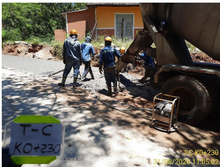
Figura 28. Fundición de losas de concreto. Obtenido en: Unión Temporal El Tarra, 2020.
