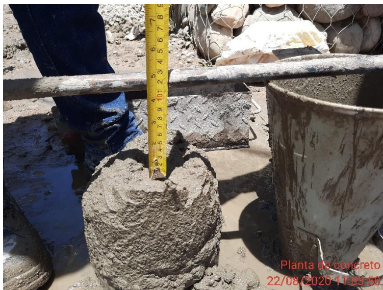
Figura 29. Asentamiento del concreto. Obtenido en: Unión Temporal El Tarra, 2020.
