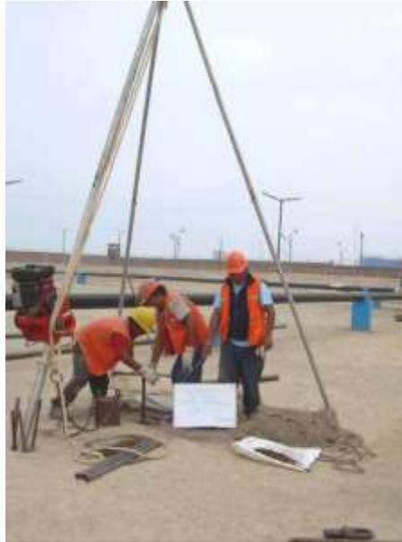
*Figura 7.* Perforación inicial antes de insertar el muestreador. Obtenido de Alva, 2016.
