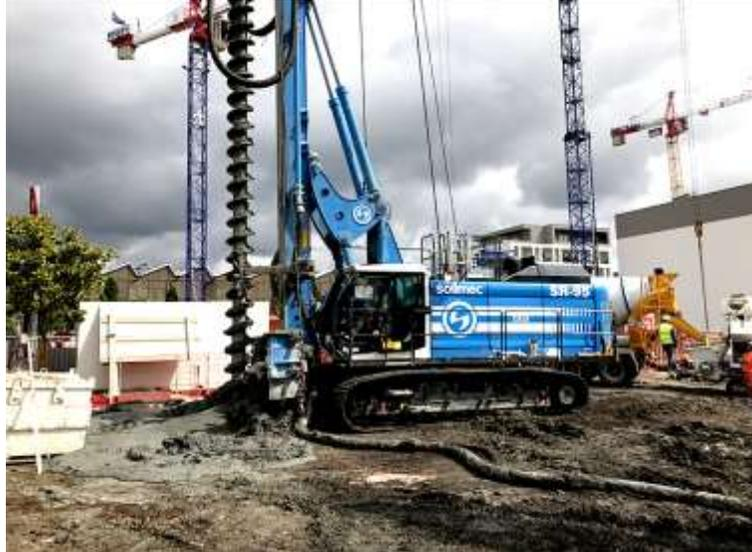
*Figura 1.* Perforación por rotación con barrena helicoidal. Obtenido en: Soilmeccolombia, 2020.
