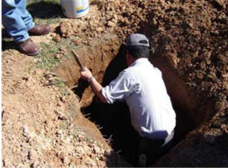
*Figura 2.* Apique efectuado con herramientas manuales. Obtenido de: Herrera & Castilla, 2012.
