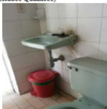
Baño Consulta Externa (residuos peligrosos)
