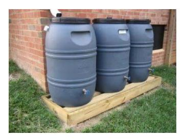
*Nota.* En la imagen se muestra el sistema de depósitos de lluvias por medio de canaletas (Codola,2015)
