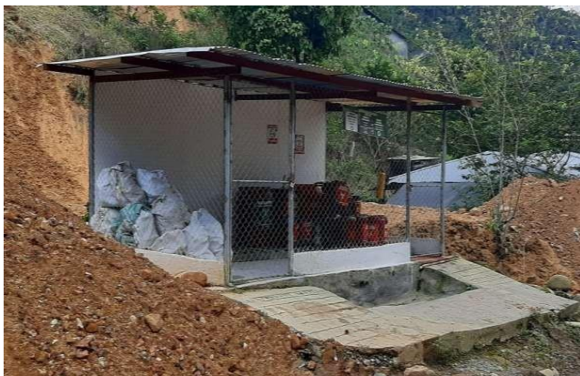
Caseta de almacenamiento de residuos sólidos
