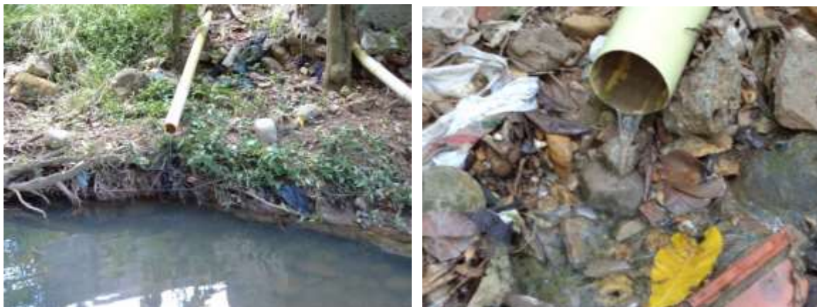
Figura 5. Puntos de vertimientos encontrados.
