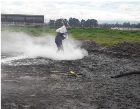
Ilustración 47. Incorporación del Cal.
