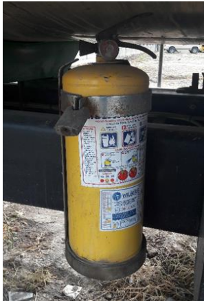
Ilustración 26. Extintor 1 Carrotanque XMB 027.
