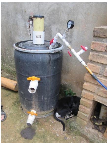
Figura 32. Biodigestor de Bidón. Predio La Quiebrita.
