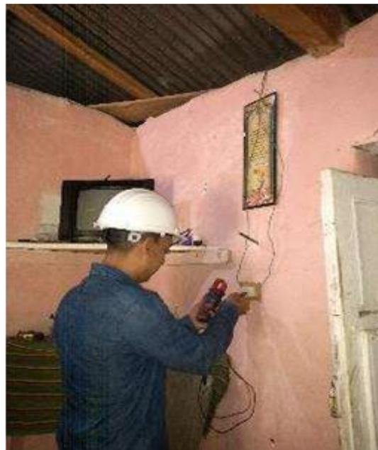
*Fotografía 18: Medición de voltaje con pinza amperimétrica en vivienda beneficiada por el sistema. Elaboración Propia*
