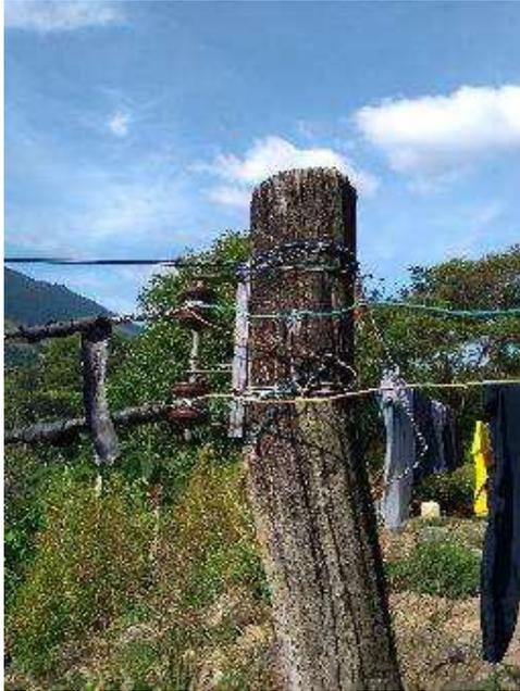
*Fotografía 7:* Estructura de madera para soporte de redes del sistema.
