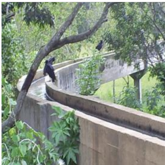
Figura 4. Canal de conducción de aguas residuales. Contraloría general del departamento de Norte de Santander (2013).
