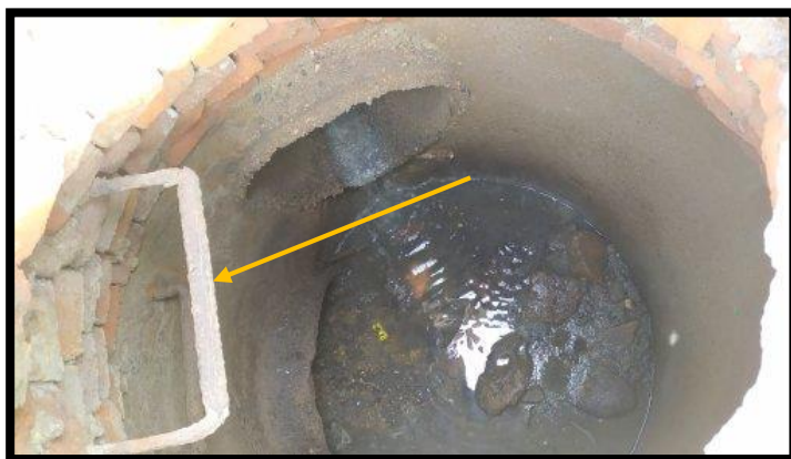
Figura 11. Peldaño del Pozo. Autor del proyecto
