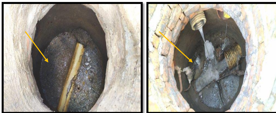
Figura 12 Cañuela del Pozo. Autor del proyecto.
