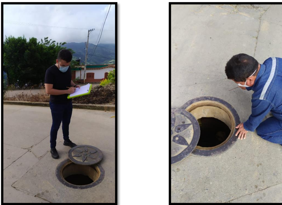
Figura 7. Inspección de pozos-Tipo de vía. Autor del proyecto
