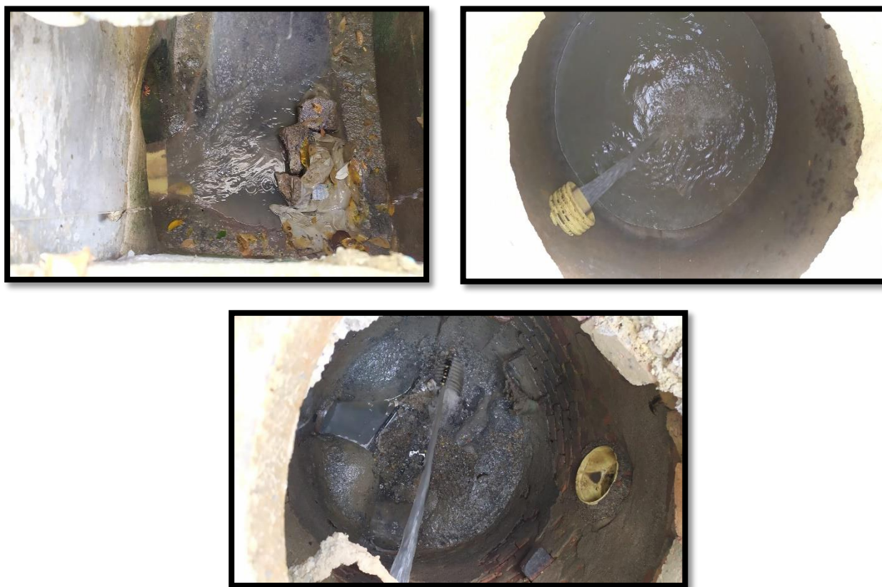
Figura 9 Inspección de pozos- Sedimentación. Autor del proyecto.
