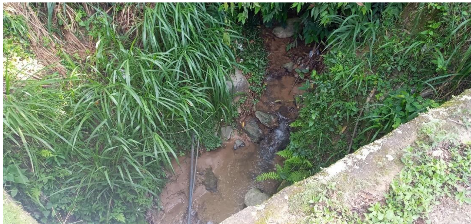
Figura 20. Vertimiento Puente La Llave Q. San Miguel. Autor, (2021).
