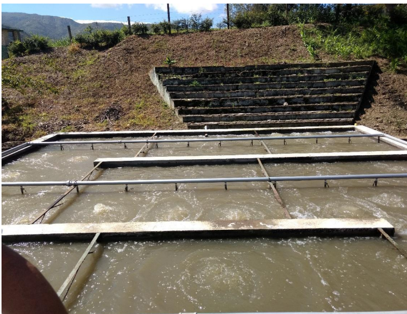
Figura 9. Proceso de aireación del STAR del Batallón Infantería N°15 General Francisco de Paula Santander. CORPONOR, informe de seguimiento al Batallón N°15 (2018).
