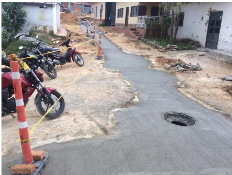
Figura 23. Reposición tubería Barrio Monte Carmelo. Obtenido de Unidad de Servicios Públicos de Convención (2018).
