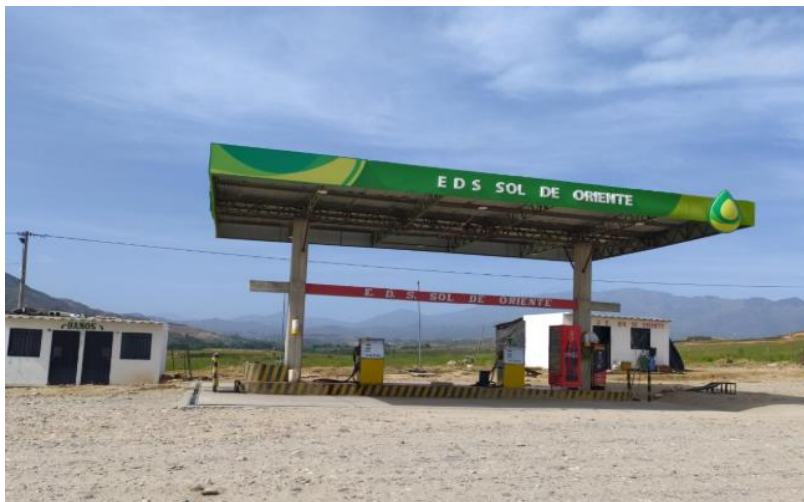
Figura 32. Panorámica de la EDS Sol de Oriente. Autor, (2021).
