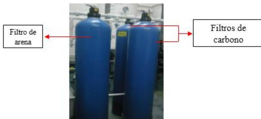
Figura 20. Batería filtrante
