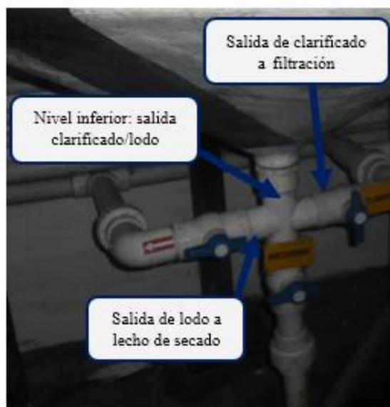
Figura 25. Diseño inicial salida de clarificado
