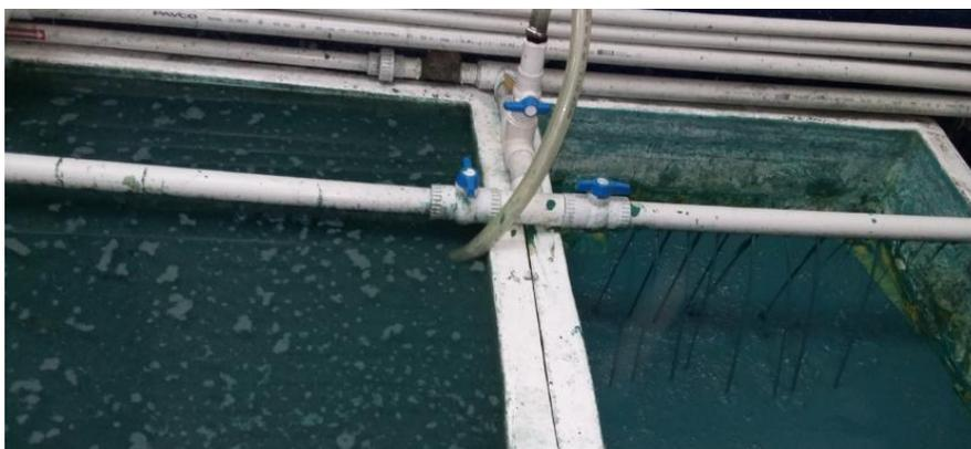
Figura 22. Lecho de secado de lodos
