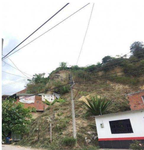
Fotografía 2. Pendiente 2 Fuente: Autor del proyecto.
