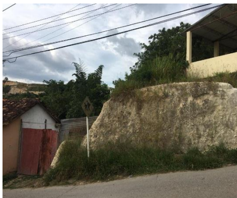
Fotografía 3. Pendiente 3 Fuente: Autor del proyecto.
