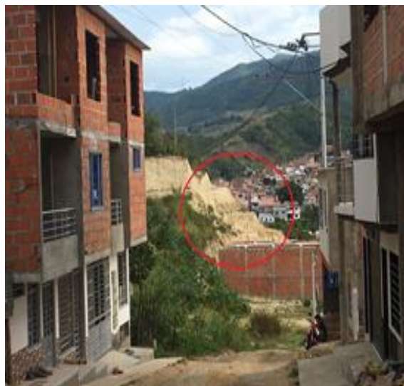
Fotografía 5. Ladera, barrio Álamos Fuente: Autor del proyecto.
