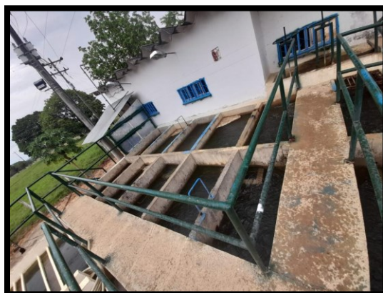
Figura 10. Unidades de floculación. Elaboración propia
