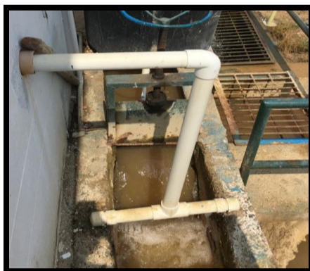
Figura 8. Canal de entrada con sección rectangular. Elaboración propia
