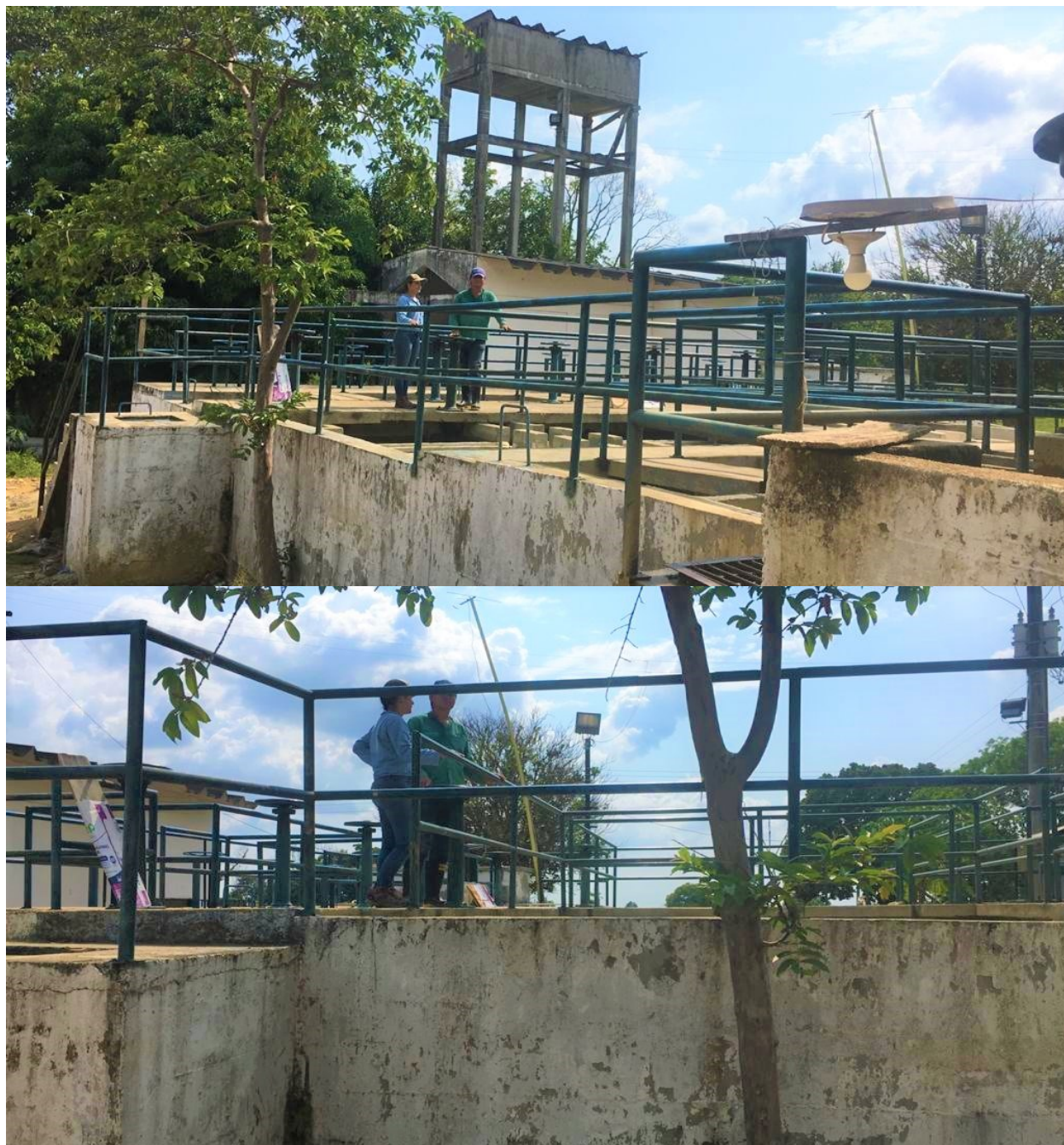
Figura 37. Visitas a la PTAP para la identificación de los procesos de tratamiento. Elaboración propia
