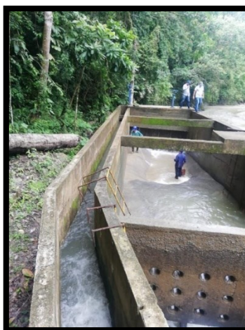
Figura 3. Desarenador-pretratamiento. Elaboración propia
