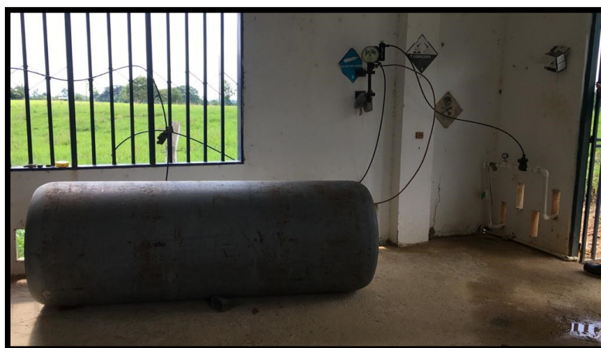
Figura 14. Área de cloración con su respectivo tanque aéreo. Elaboración propia
