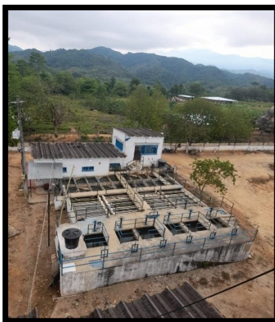
Figura 4. Planta de tratamiento de agua potable en San Martín, Cesar (PTAP). Elaboración propia
