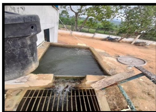
Figura 5. Cámara de aquietamiento en PTAP. Elaboración propia
