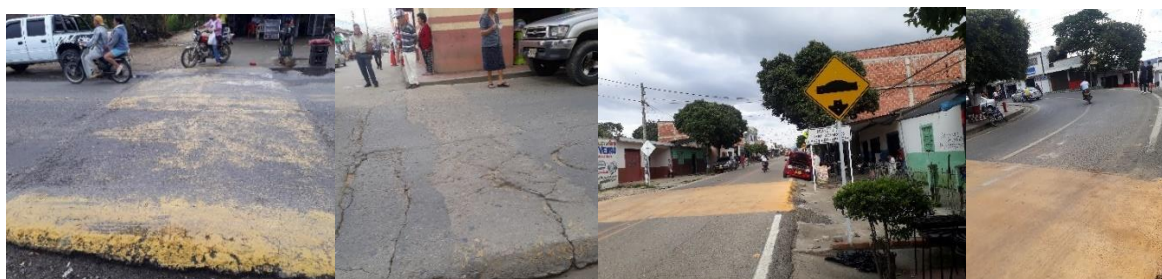
Figura 11. Reductores de velocidad en la carrera 5 y 6 del municipio. Fuente. Elaboración propia (2019).
