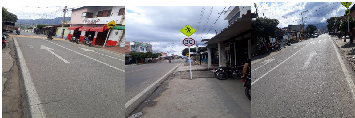
Figura 16. Tramo de Vía que se encuentra en las mejores condiciones y que cumplen con la normatividad vigente. Fuente. Autor del proyecto (2019).
