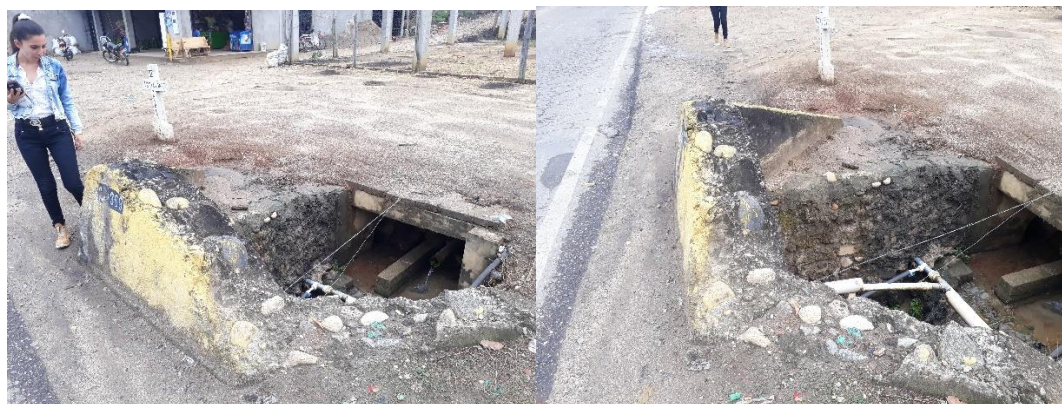
Figura 20. Alcantarilla en mal encontrada en el casco urbano del municipio. Fuente. Elaboración propia (2019).
