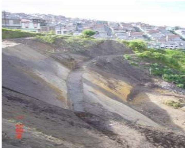
Figura 14. El perfilado del talud Fuente: http://www.bdigital.unal.edu.co
