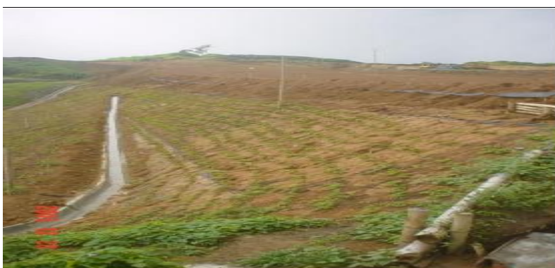
Figura 16. Talud de un terraplén con establecimientos de vegetación nativa de la zona. Fuente: http://www.bdigital.unal.edu.co
