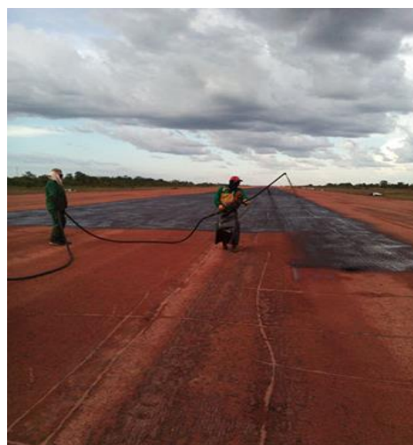
Fotografía 36. Imprimación asfáltica. Fuente: Autor del proyecto (2019).
