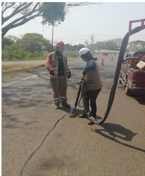
Fotografía 32. Sello de fisuras. Fuente: Autor del proyecto (2019).
