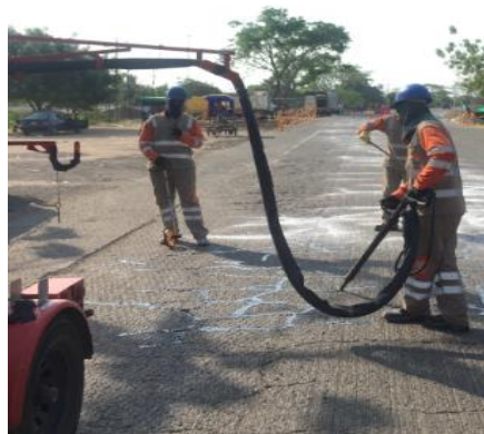
Fotografía 16. Conducción del material sellante hacia la pistola. Actividad de sello de fisura. Fuente: Autor del proyecto (2019).
