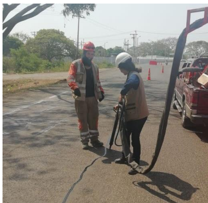
Fotografía 17. Sello de fisuras. Fuente: Autor del proyecto (2019)
