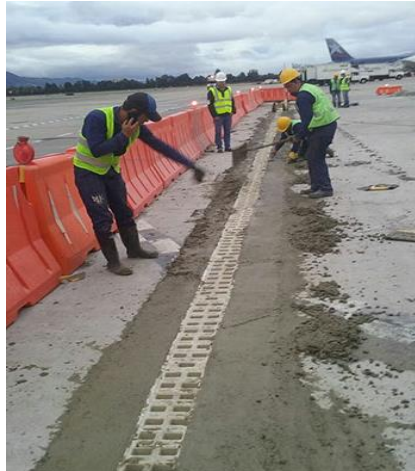
Fotografía 37. Obra civil, Adecuación rejilla para agua lluvia. Fuente: Autor del proyecto (2019).
