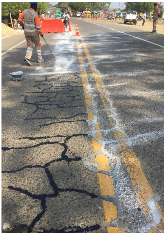
Fotografía 40. Sello de Fisuras en la Vía Ponedera-Suan, Atlántico. Fuente: Autor del proyecto (2019)
