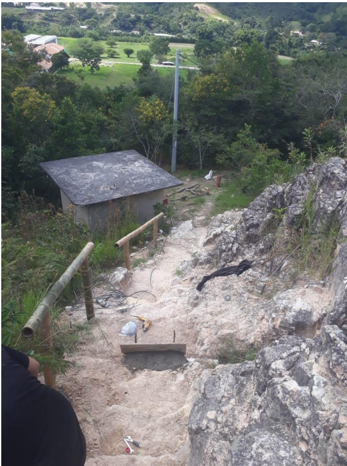
Instalación de pasamanos que faciliten el tránsito en los escalones que se encuentran en el recorrido del aula ambiental a al mirador de planta física de la Universidad.
