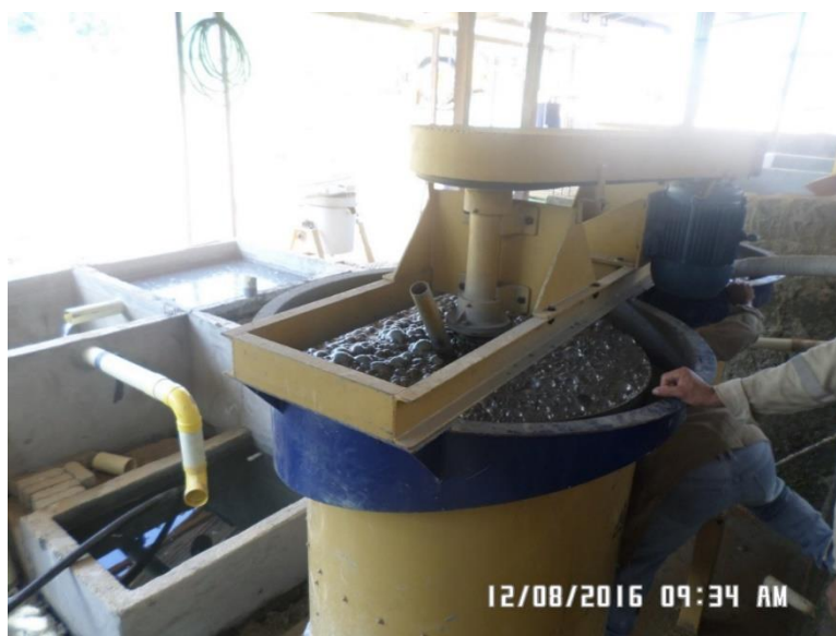
Fotografía 4. Celdas de flotación
