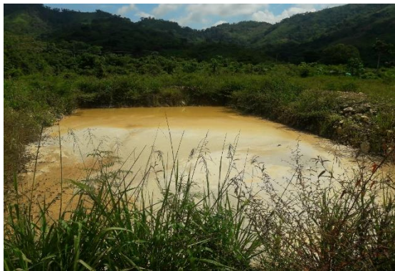
Fotografía 19. Piscinas de retención de sólidos y líquidos
