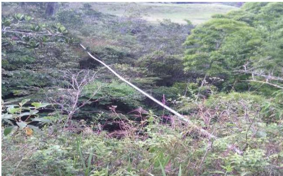
**Fotografía 24. Conducción en tubo de PVC Reservoirio Venadillo.**
