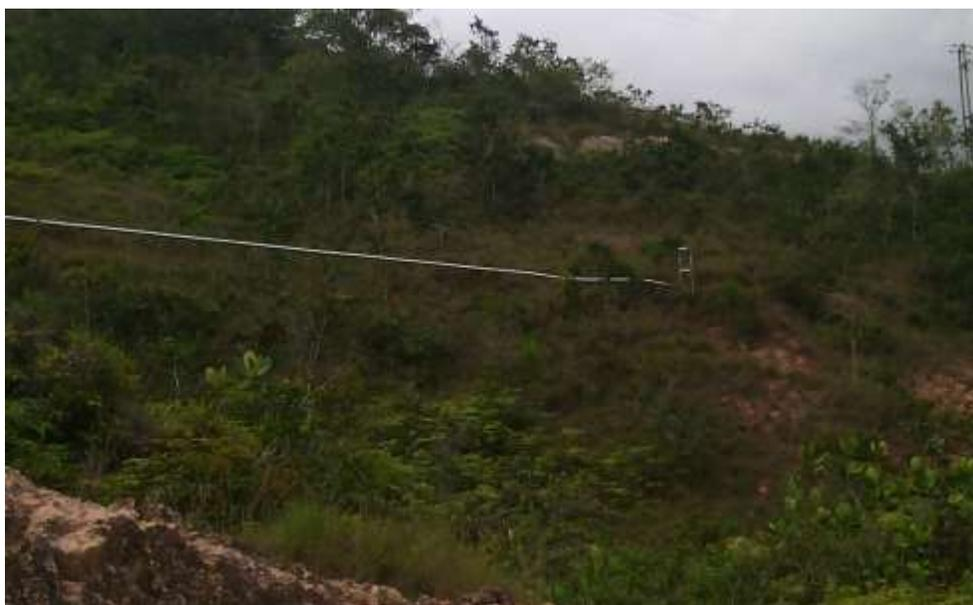
**Fotografía 20. Conducción en tubo de PVC Reservoirio Santa Lucia.**
