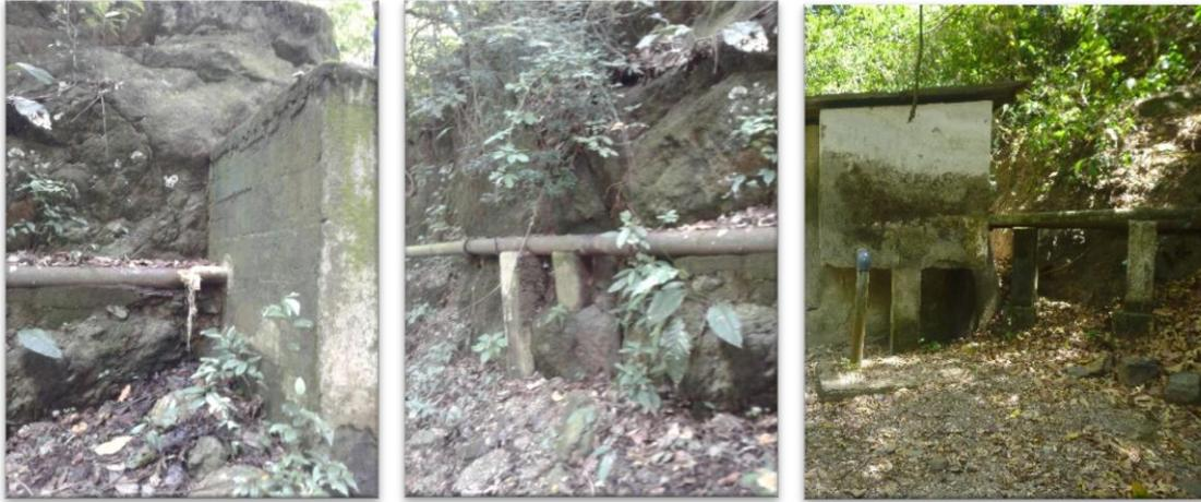
**Figura 9. Aducción hasta el desarenador de la Quebrada el salto**
