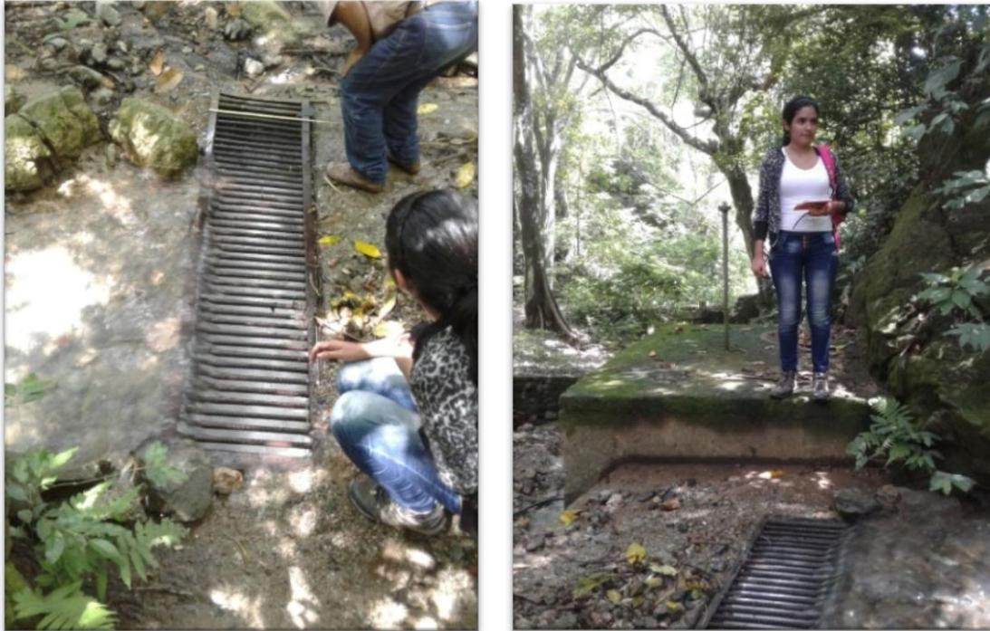
**Figura 8. Bocatoma y Cámara de recolección Q. El Salto Fuente. Pasante del proyecto**
