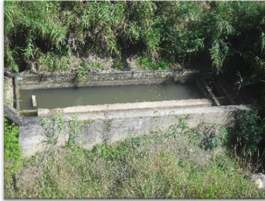
**Figura 27. Desarenador de la Quebrada el Tabaco**
