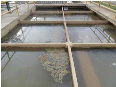
**Sedimentacion:** El sistema se encuentra compuesto por dos sedimentadores con dos modulos rectangulares cada uno. Sus dimensiones son: 38,26 m de largo, 6 metros de ancho y 3,50 metros de profundidad. Para un tiempo total de retencion del agua de 3 horas,
