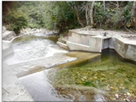
**Figura 23.** Estructura de la bocatoma Río Oroque
