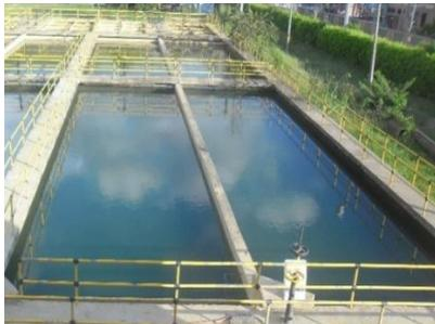
**Filtracion:** El lecho filtrante se realiza en una unidad de filtracion con cuatro modulos estan compuesto por una capa de grava, gravilla, arena y antracita que entran a un falso fondo. Las dimensiones de los filtros son: 6,10 metros de largo, 6,17 metros de ancho y 1,40 metros de profundidad.
