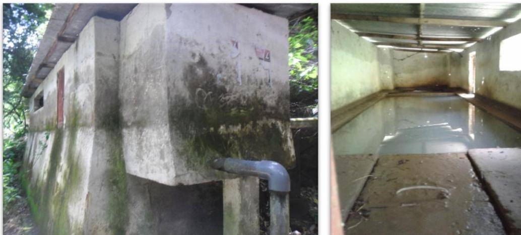
**Figura 10. Desarenador Quebrada El Salto**
