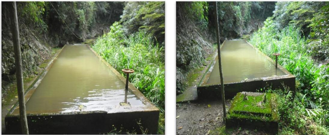
**Figura 40. Desarenador de la Planta el Llanito
