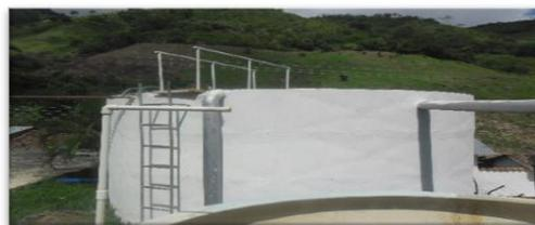
La PTAP está conformada por un cilindro exterior y uno interior con una capacidad de  $10 \text{ m}^3$ ; el cilindro exterior tiene diámetro de 4,94 m, fabricado en concreto reforzado, mientras que el cilindro interior está construido en lamina de acero con un diámetro de 2.0 metros
