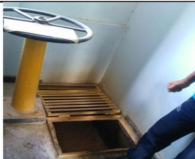
**Mezcla rapida:** Se realiza en la canaleta parshall en la cual se mide el caudal que ingresa a la planta, se distribuye uniformemente el sulfato de aluminio y la cal al agua en un tiempo no superior a 30 seg.
