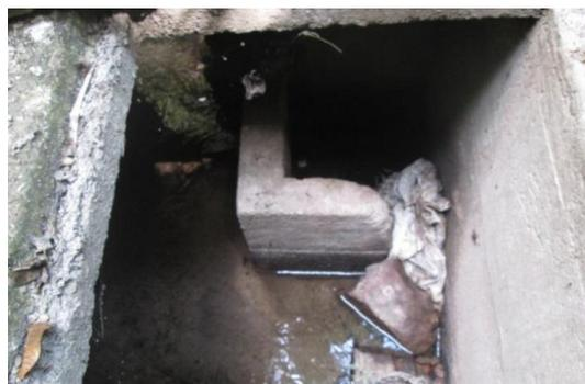
**Figura 49. Bocatoma y Cámara de quietamiento Quebrada la Honda.**
