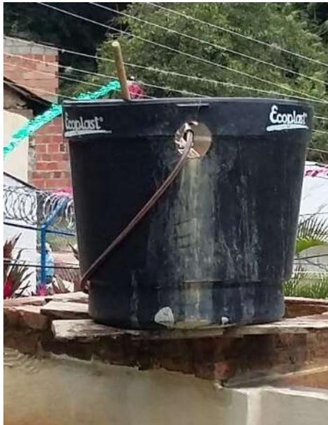
**Nota.** La primera foto refleja la captación de la Quebrada El Tigre, dando lugar a la segunda donde se observa la línea de aducción y por último la tercera foto muestra el mecanismo que utilizan para agregar el coagulante y es claro que no es el adecuado y este es proporcionado manualmente. Fuente. Autores del Proyecto (2016).
