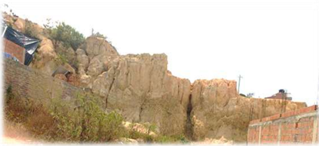
Fotografía 12. Punto susceptible a remoción en masa barrio ciudadela deportiva.
