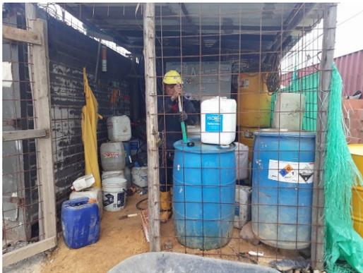
El cuarto de sustancias químicas, donde se realiza, manipulación, trasvase y transporte de las mismas, para el lavado de fachada se utiliza ácido nítrico y ácido fluorhídrico, y para el impermeabilizado de fachadas se utiliza la Zika 10.
