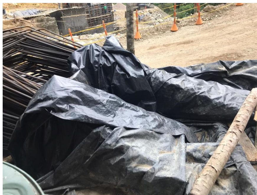
Figura 47. Protección y cubrimiento de materiales
