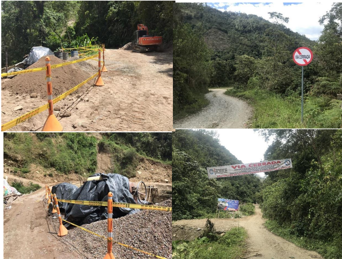
Figura 48. Señalización y cierres de vía
