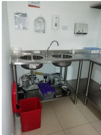
Ilustración 5 Trabajo Sucio sala de procedimientos Fuente: Autor del proyecto
