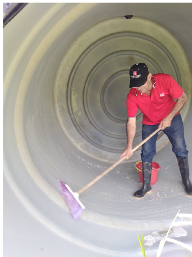
Foto 3. Desinfección adecuada del tanque de almacenamiento de agua
