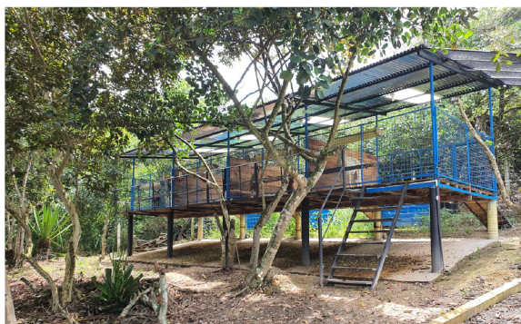
Foto 10. Foto Instalaciones elevadas
