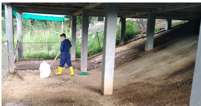
Foto 9. Instalaciones de fácil limpieza y desinfección
