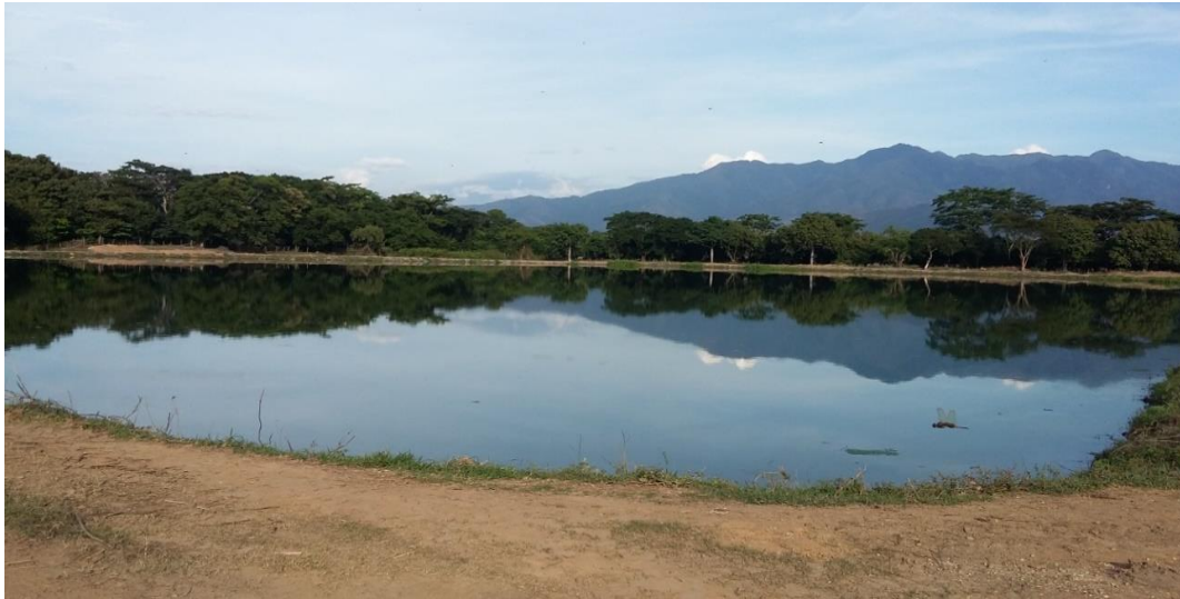
Figura 8. Laguna de estabilización N° 2
