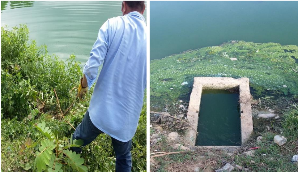
Figura 4. Diques del STAR.
