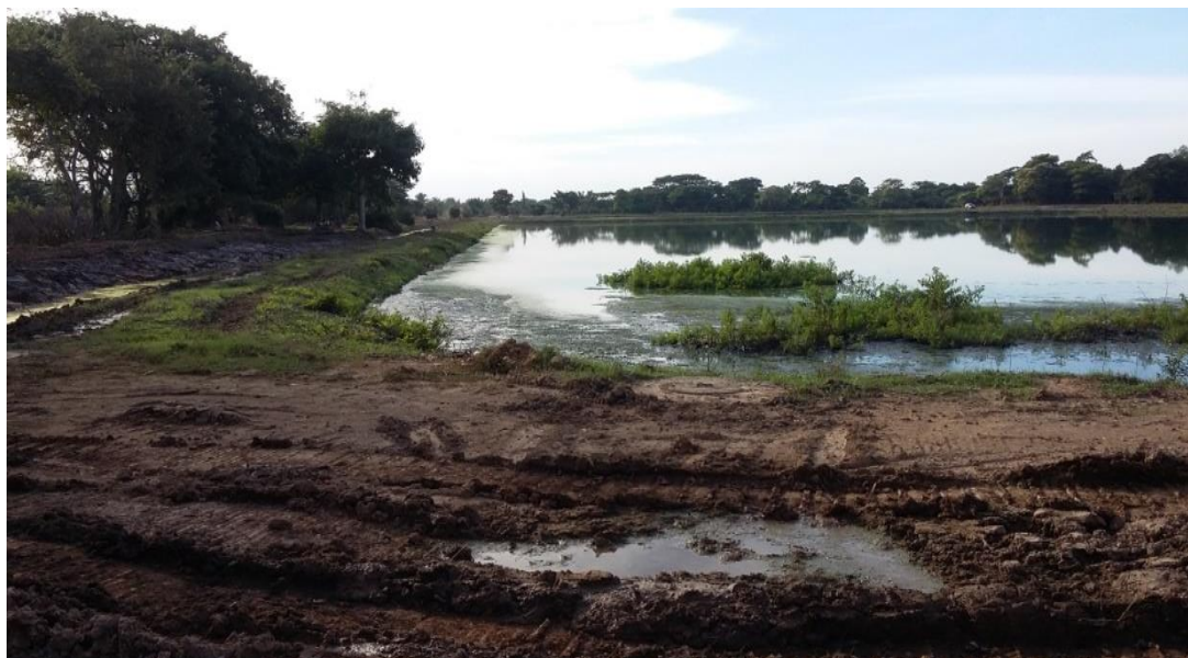
Figura 7. Laguna de estabilización N°1 del municipio de Curumani.
