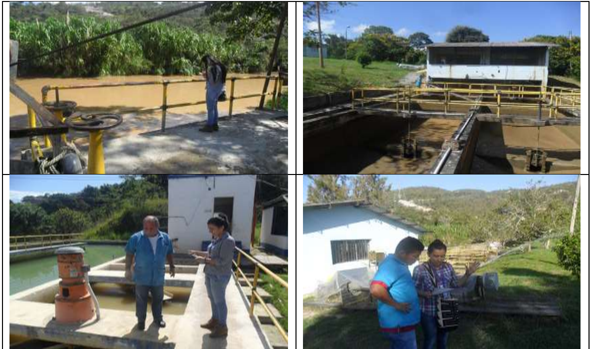
Fotografía 2. Visita a plantas de tratamientos.
