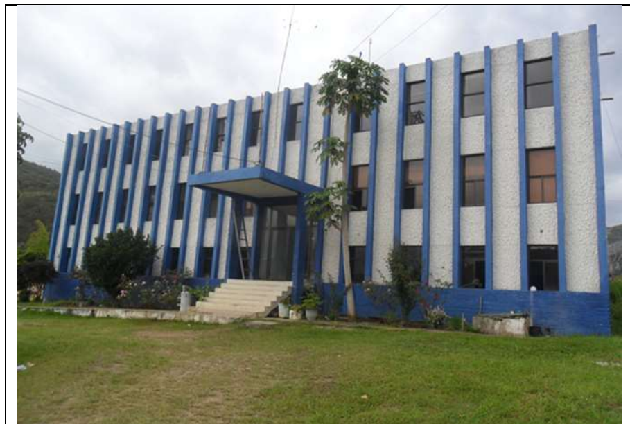
Fotografía 4. Planta de tratamiento el Algodonal.
