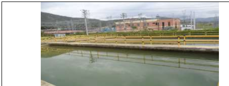
Fotografía 14. Sistema de sedimentación de la planta de tratamiento el Algodonal.
