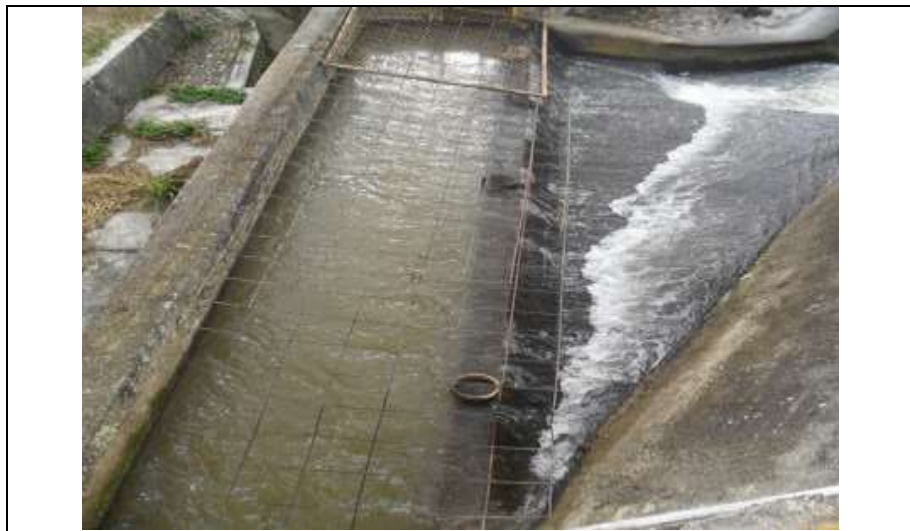
Fotografía 6. Canal de conduccion de la planta de tratamiento el Algodonal.
