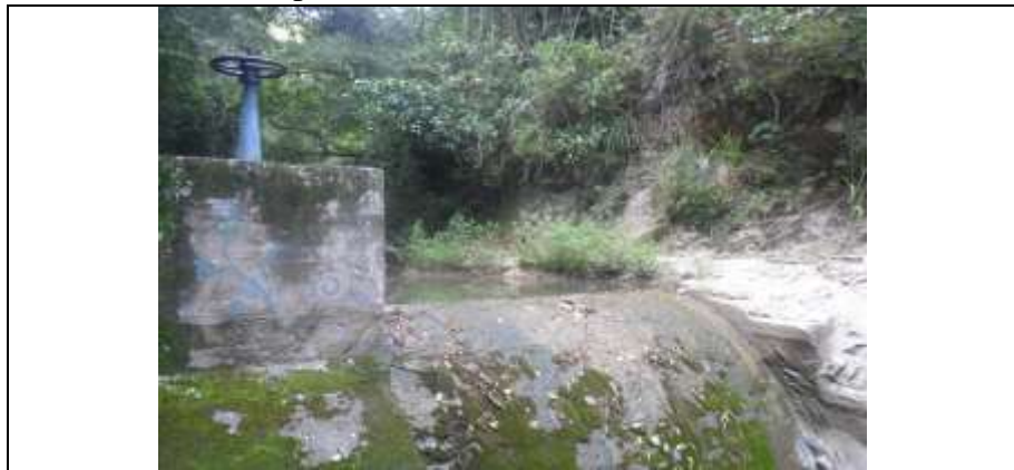
Fotografía 20. Bocatoma La Tupia.
