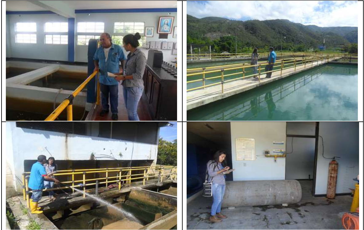
Fotografía 3. Identificación de los sistemas de agua potable.
