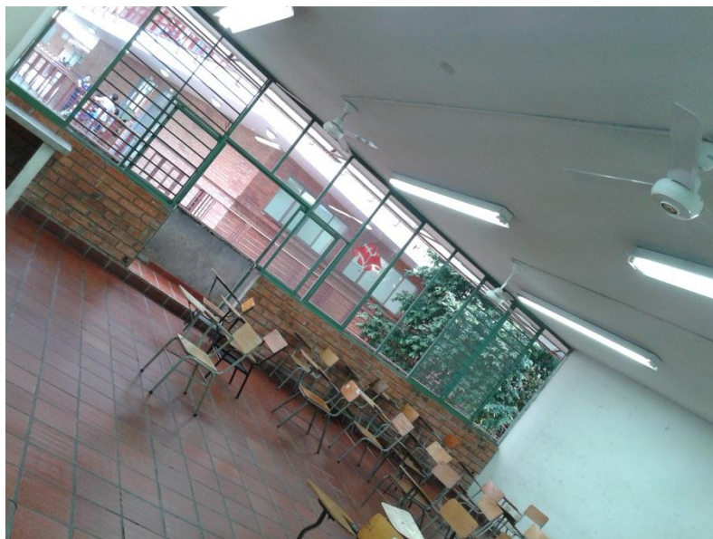
Figura 29 evidenciamos el mal uso de la energía artificial en uno de los salones del Edificio Aula Sur, U.F.P.S, Sede colsag
