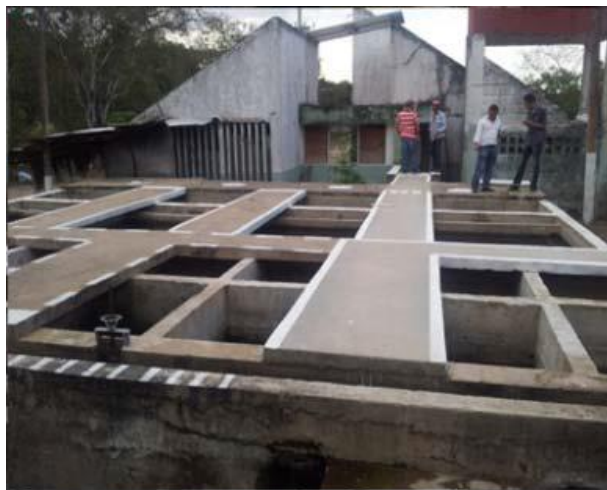
Fotografía 11. Vista General Planta No. 1. Vista hacia aguas abajo
