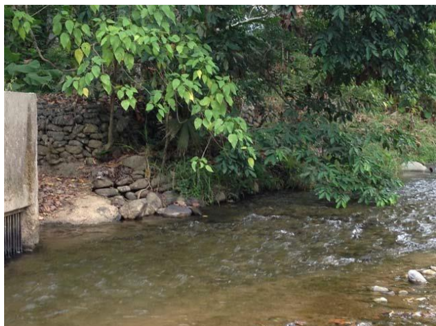
Fotografía 8. Detalles de inestabilidad de taludes
