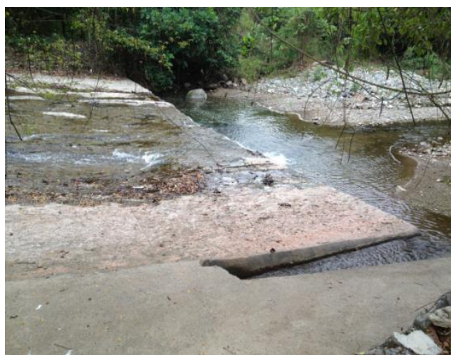
Fotografía 1. Bocatoma sobre el Río Sororia, Canal de Excesos.
