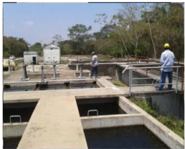
Fotografía 14. Vista general de la Planta No. 2. Vista hacia aguas abajo.
