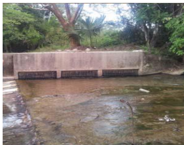
Fotografía 2. Rejillas laterales y de fondo de la Bocatoma
