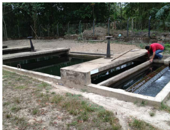
Fotografía 4. Desarenador No. 2. Se aprecian compuertas de lavado y vertedero de salida.
