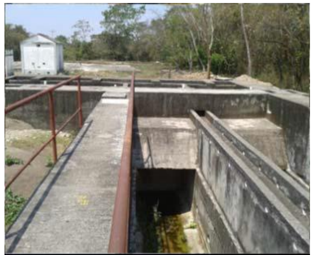
Fotografía 17. Estructura del sedimentador en la Planta No. 3. Vista hacia aguas abajo.
