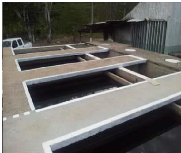
Fotografía 12. Filtros de la Planta No. 1. Sentido del flujo hacia la derecha
