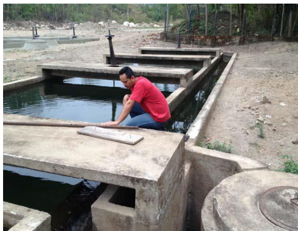
Fotografía 3. Desarenador No. 1. Nótese el canal de excesos. Vista hacia aguas arriba.
