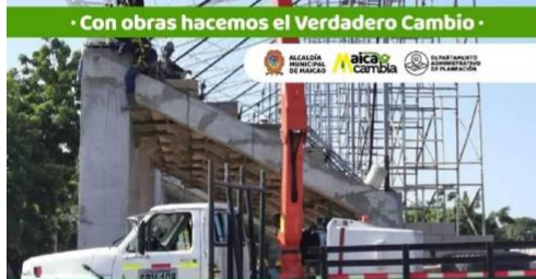
Instalación cubierta metálica en la cancha del barrio 20 de julio.
