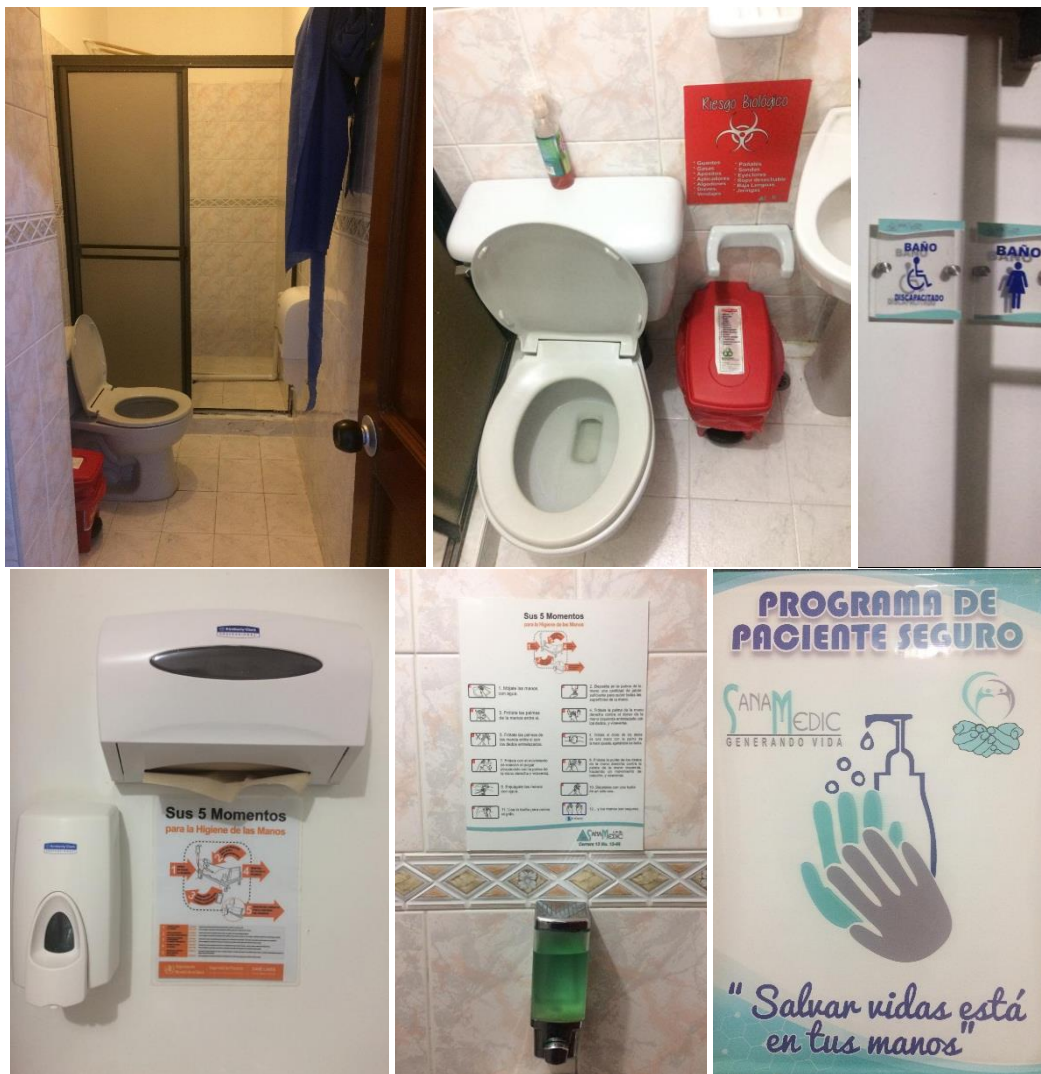
Sanitarios de la IPS en excelentes condiciones, con recipientes adecuados y con señalización e información de higiene.
