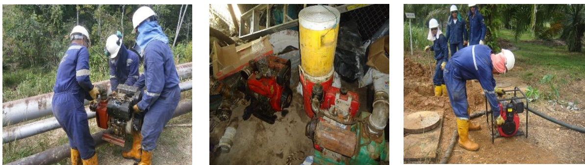
Figura 26. Inspección de motobombas
