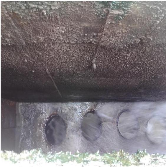
Fotografía 15. Canal de reparto a sedimentadores
