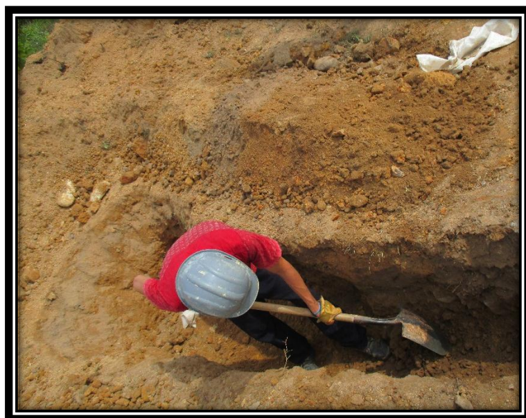
Fotografía 3. Excavación para instalación de tubería a mano
