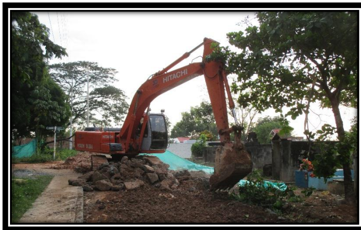
Fotografía 11. Demolición de pavimento
