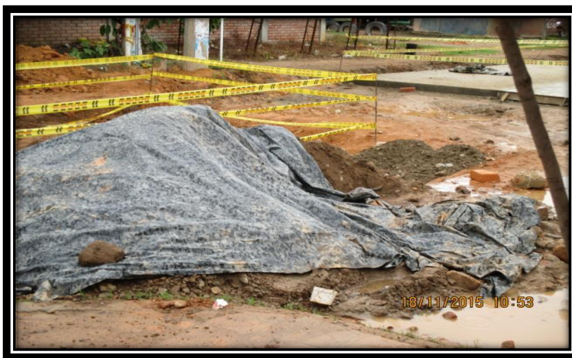
Fotografía 29. Tapado de material sobrante
