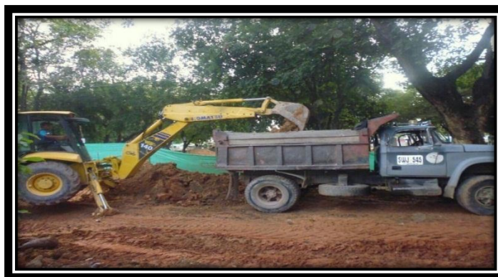
Fotografía 37. Retiro de material sobrante
