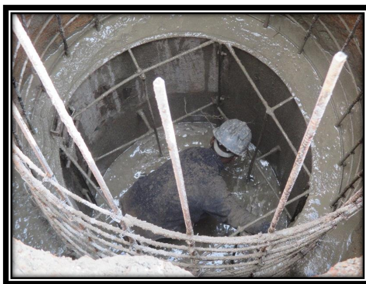
Fotografía 7. Pozo de inspección con hierro de refuerzo
