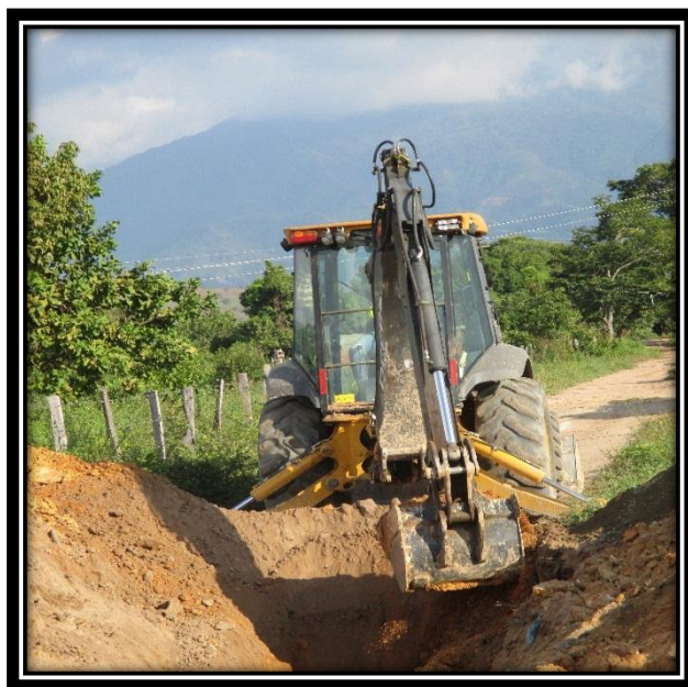
Fotografía 2. Excavación para instalación de tubería a Maquina
