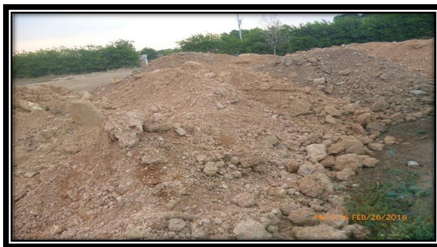
Fotografía 38. Centro de acopio de material sobrante
