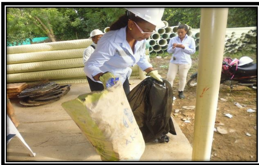
Fotografía 33. Limpieza del campamento
