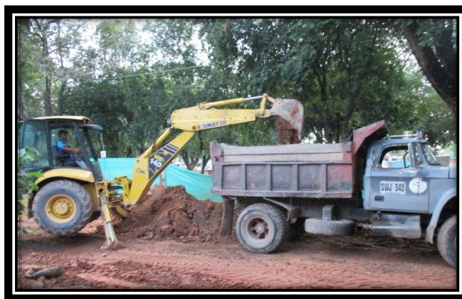
Fotografía 12. Retiro de material sobrante
