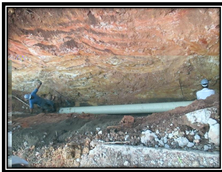
Fotografía 5. Instalación de Tubería
