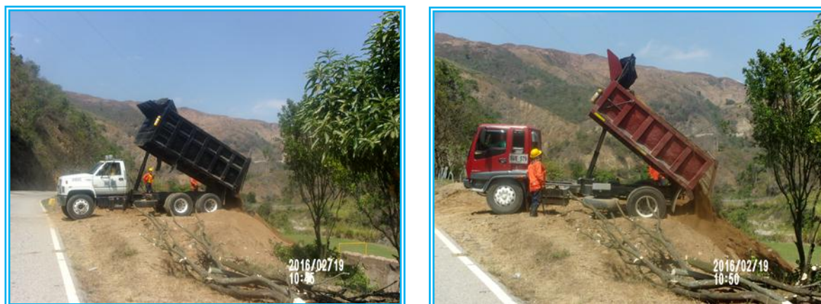
Figura 15. Disposición Final de Escombros – ZODME
