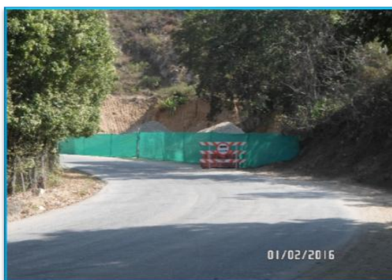
Figura 5, Señalización de los materiales en frentes de trabajo.
