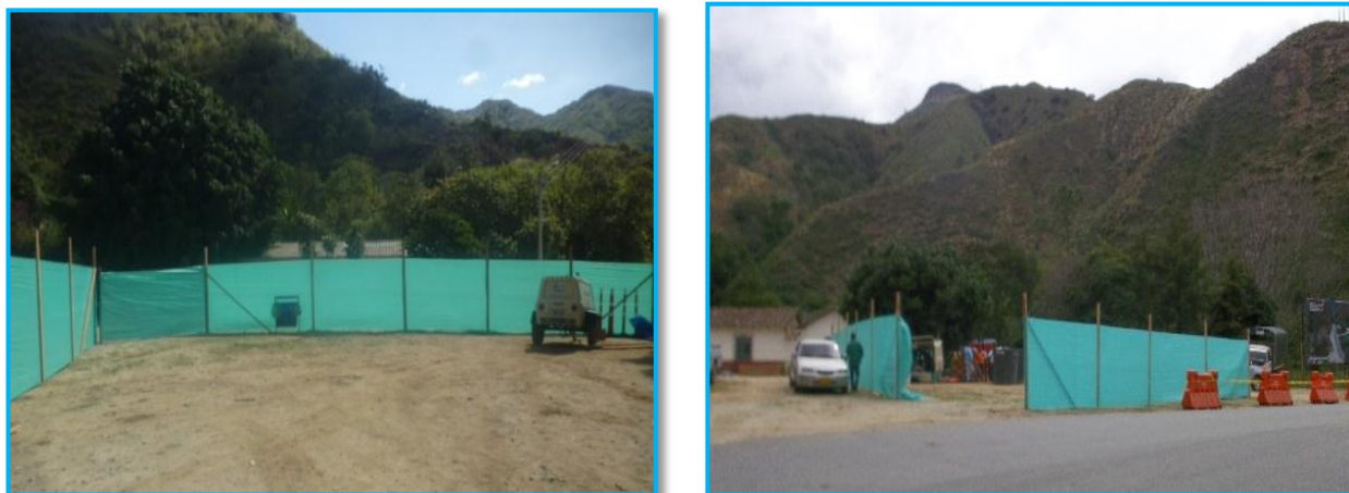
Figura 23. Cerramiento del área del campamento.
