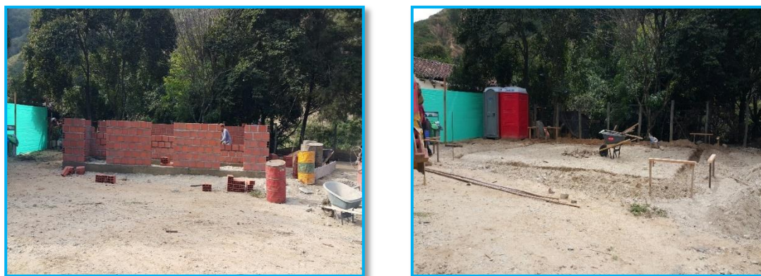
Figura 24. Construcción del campamento.
