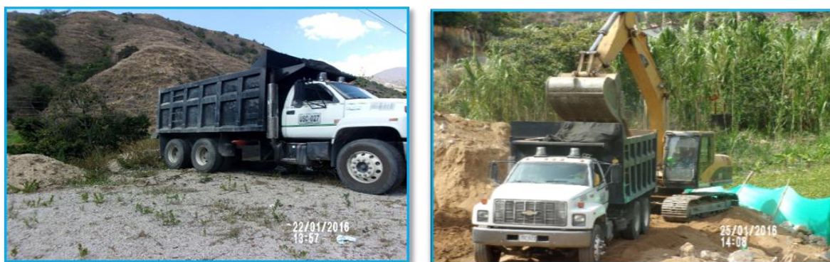
Figura 14. Transporte de material en volqueta.
