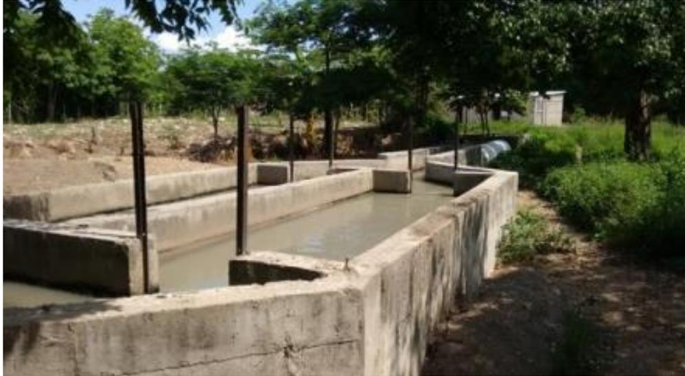
Figura 18. Estructura de entrada del sistema de tratamiento de aguas residuales. Fuente. Autor de la pasantía.
