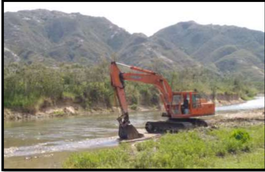
Fotografía 1. Retroexcavadora utilizada para extraer material de arrastre por Provias
