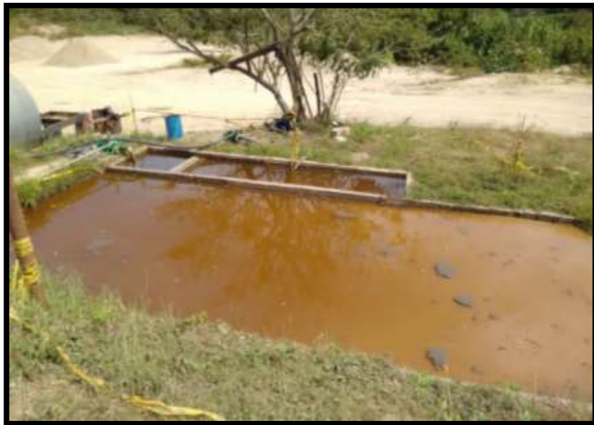
Fotografía 6. Tanque sedimentado de aceites sin delimitaciones
