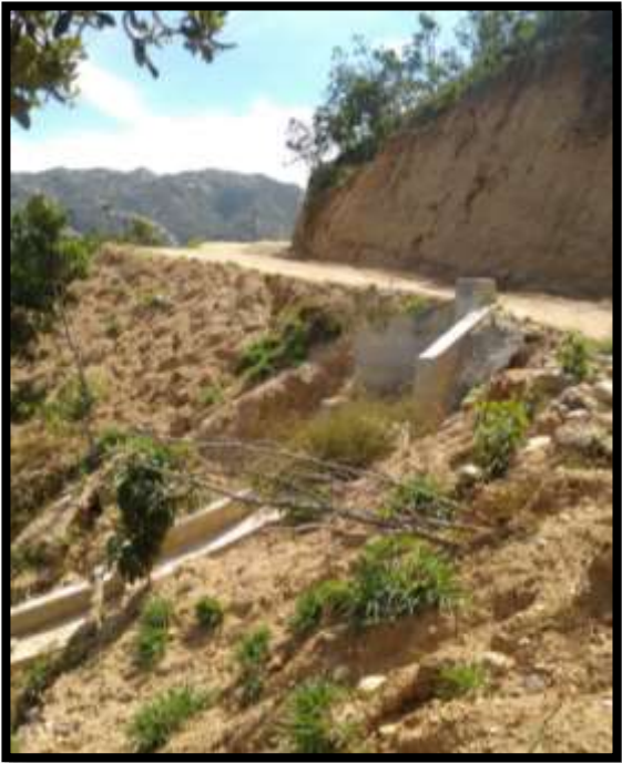
Fotografía 3. Obras de drenaje sobre la vía
