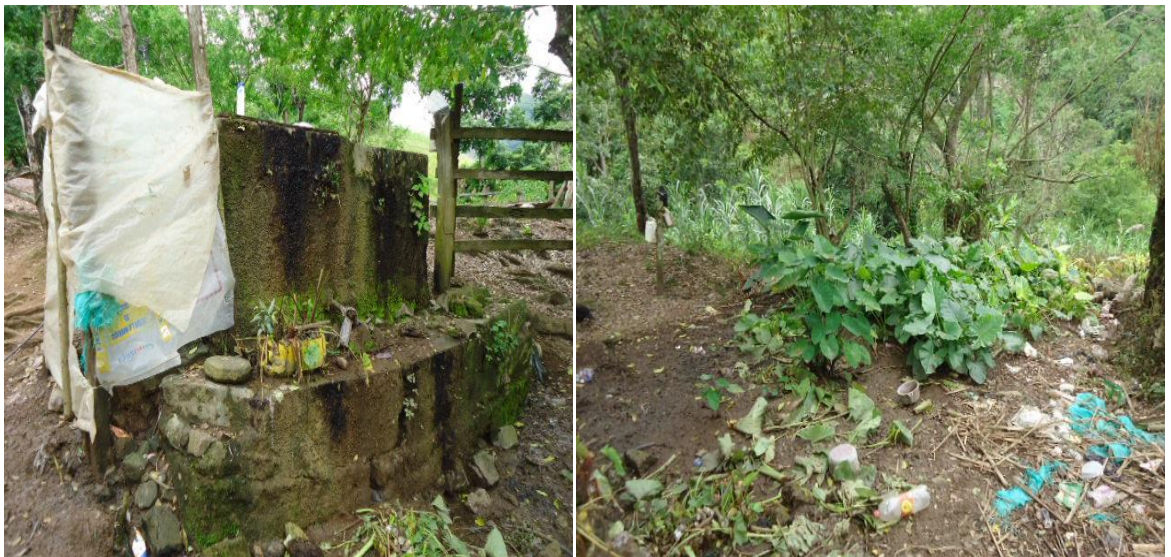
Vertimiento de las aguas directamente al suelo sin ningún tratamiento adicional, los predios están ubicados en la parte alta de la Cuenca, estas aguas solo llegan a la Cuenca en épocas de lluvia por escorrentía. Los residuos sólidos los amontonan y en ocasiones los incineran.
