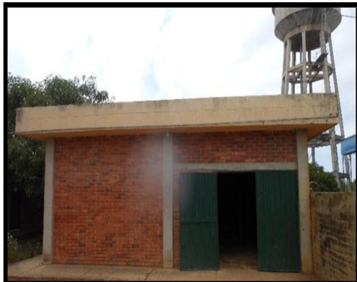
Fotografía 6. Área de máquinas
