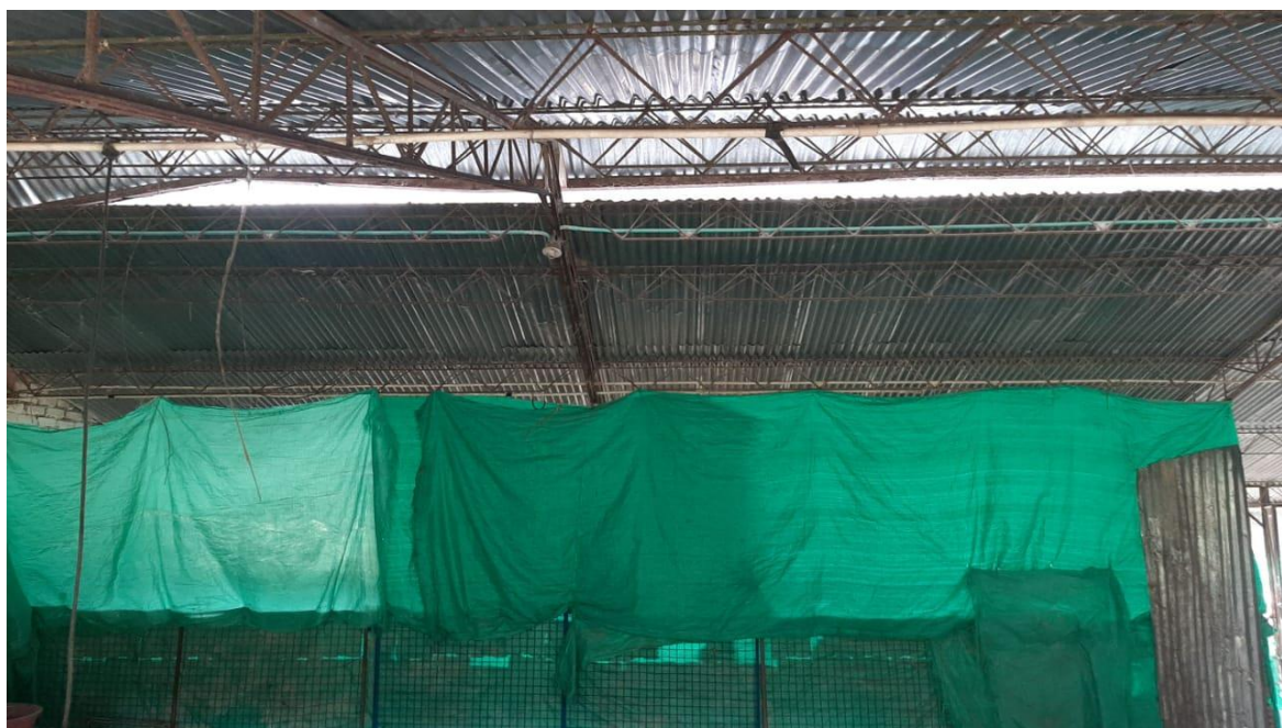
Figura 7. Interior de galpón de investigación. Fuente: autor del proyecto
