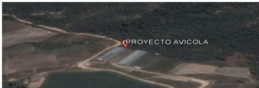
Figura 1. Vista aérea Proyecto Avícola Ufpso
