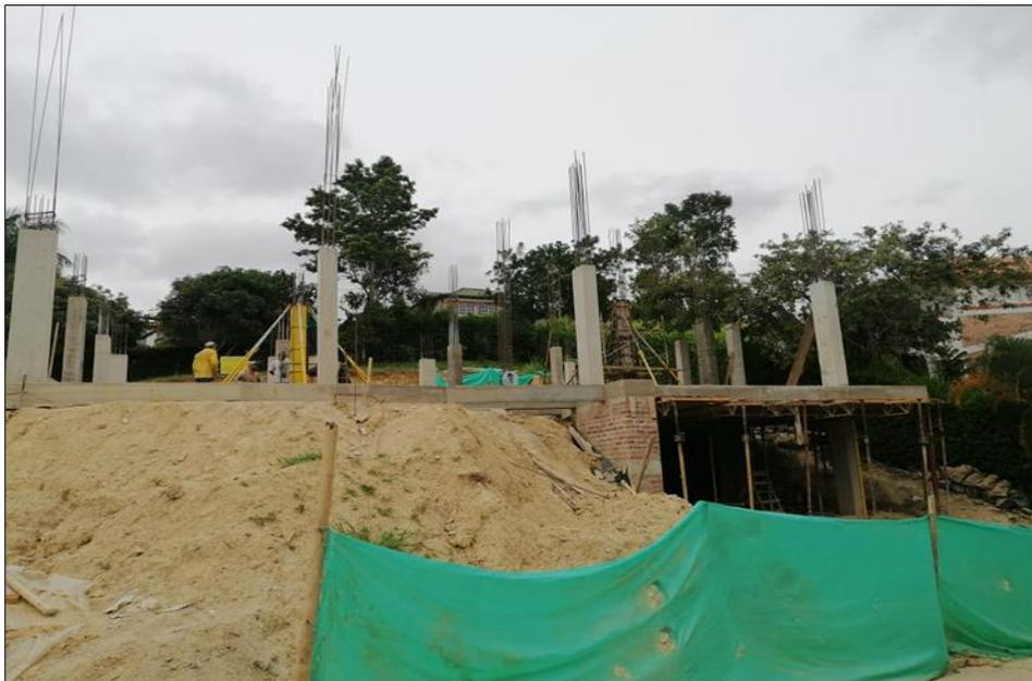
**1.1.5.1 Generalidades del proyecto.** Actualmente el proyecto se encuentra en la etapa de vaciado de columnas, por lo tanto, las actividades que se están llevando a cabo son el figurado y armado de acero de columnas, encofrado, y finalmente su vaciado para el posterior armado de la losa de entrepiso, como se puede observar en las Figuras 5 a la 7.
