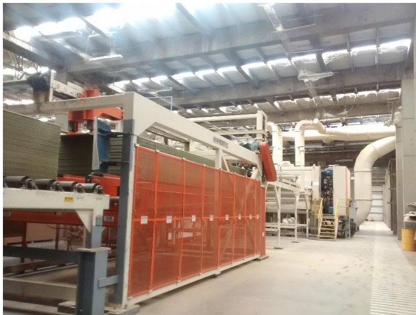
Figura 14. Zona de lijado. Fuente: Autor del proyecto.
