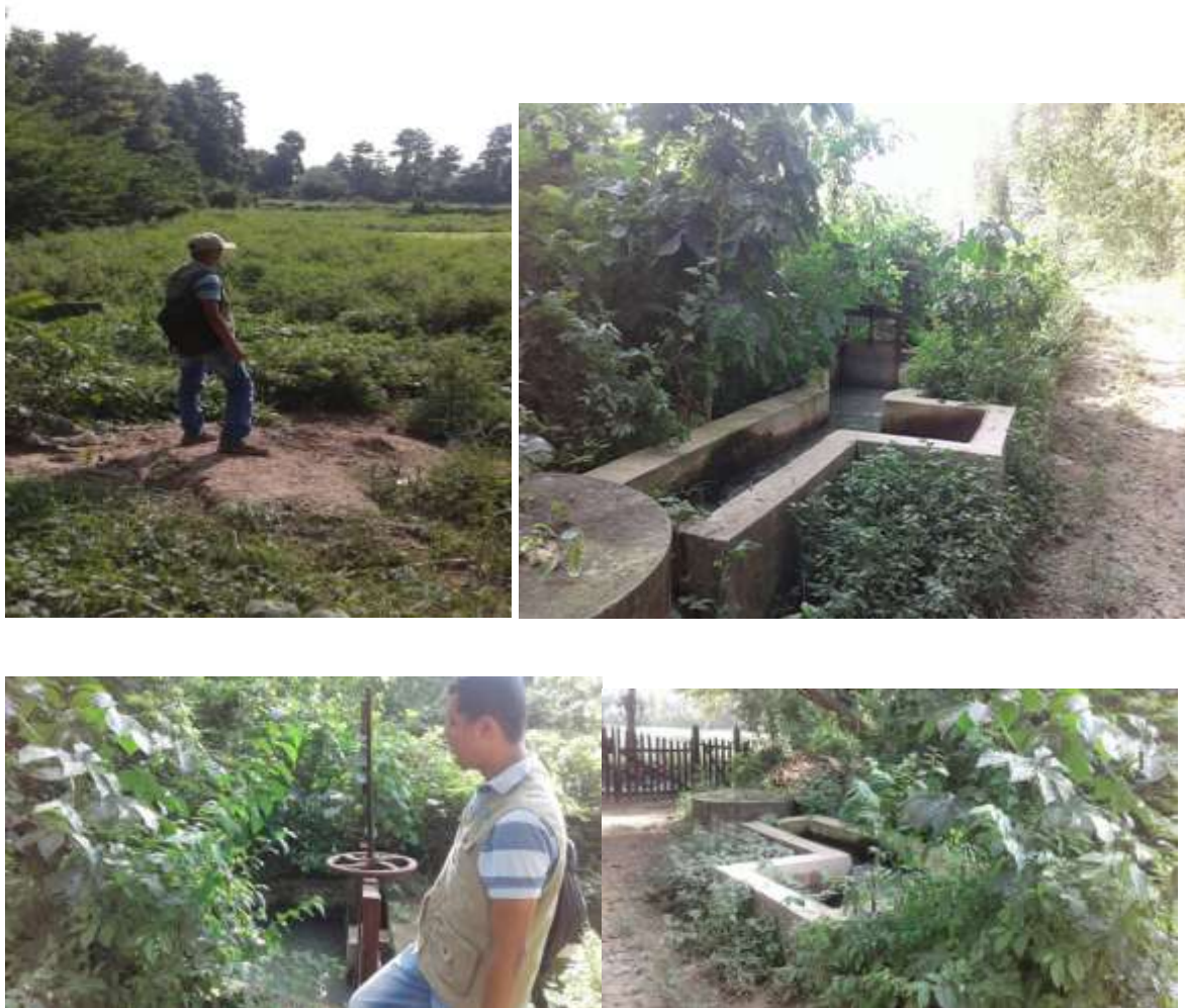
Figura 13. Visita técnica al sistema de tratamiento de aguas residuales
