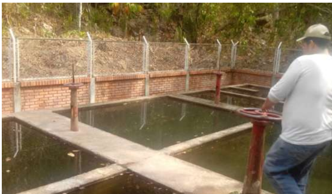
Figura 16. Visita a la bocatoma
