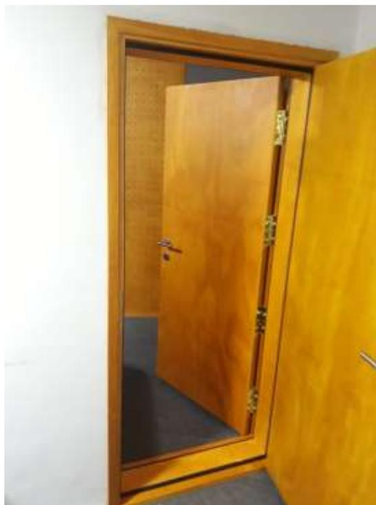
**Figura 13.** Puerta interna y externa de la cabina de radio tratada acústicamente
